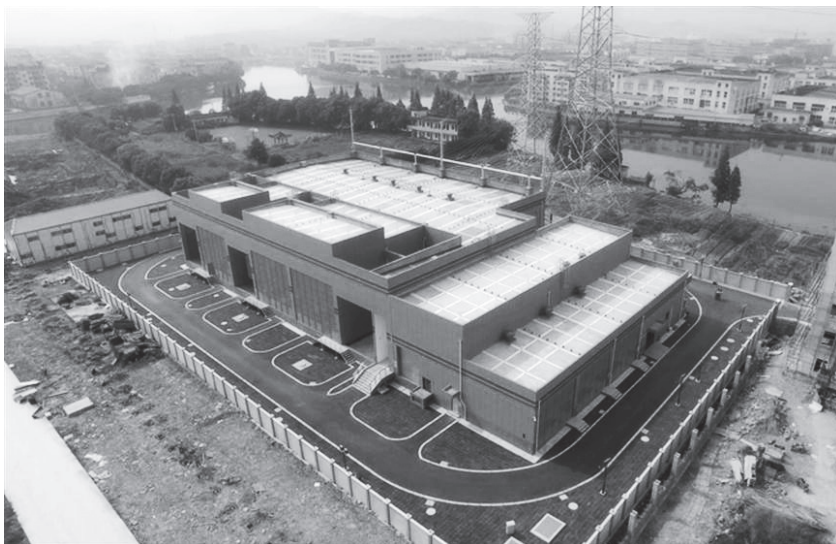
10月21日, 220千伏余渚变电站投入运行(王乾鹏摄)
