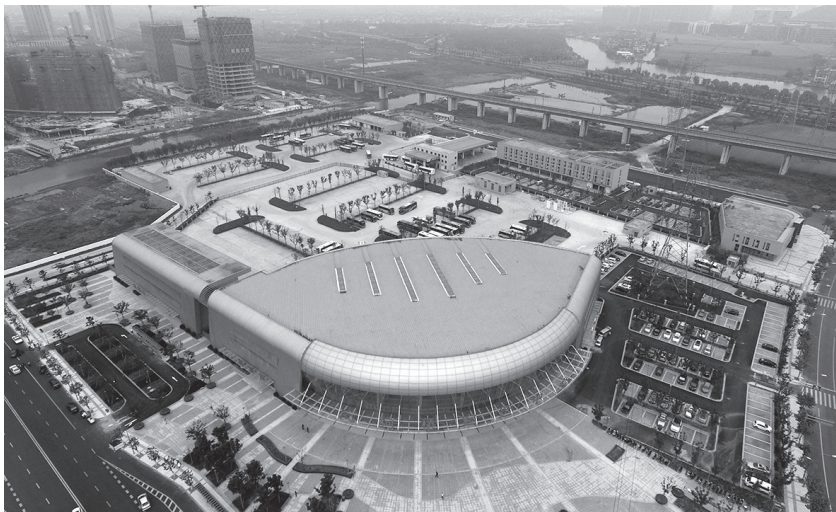
10月28日,柯桥客运中心全面启用
