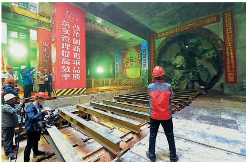
图 30 2018年10月30日，杭临城际铁路工程“第一洞贯通”
