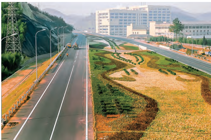
图 206 2014 年 12 月, 15 省道与 02 省道连接线改建工程(长西线)非城区段 16.1 千米建成
