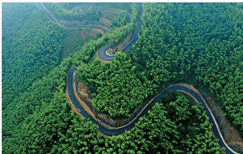
图 192 “四好农村路”石部线公路（区交通运输局提供）
