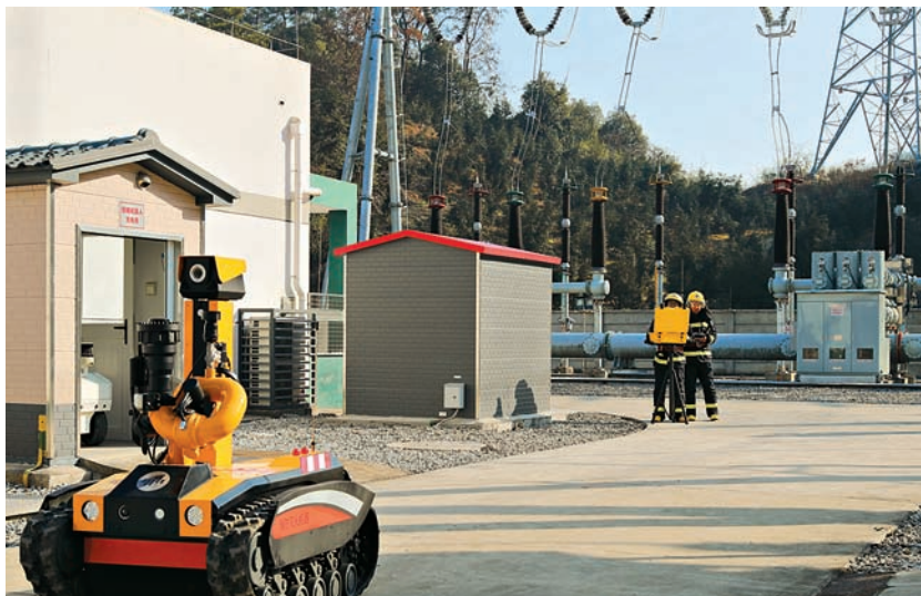
图198 2020年11月18日,区供电公司首次在220千伏柯家变电站投入履带式消防机器人(区供电公司提供)
