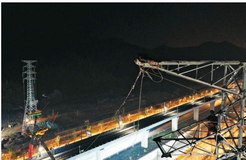
图 199 2020 年 12 月 23 日，区供电公司完成跨越杭州地铁 16 号线的 110 千伏岗科线、科创线 12 号至 13 号铁塔导线拆除工程（区供电公司提供）
