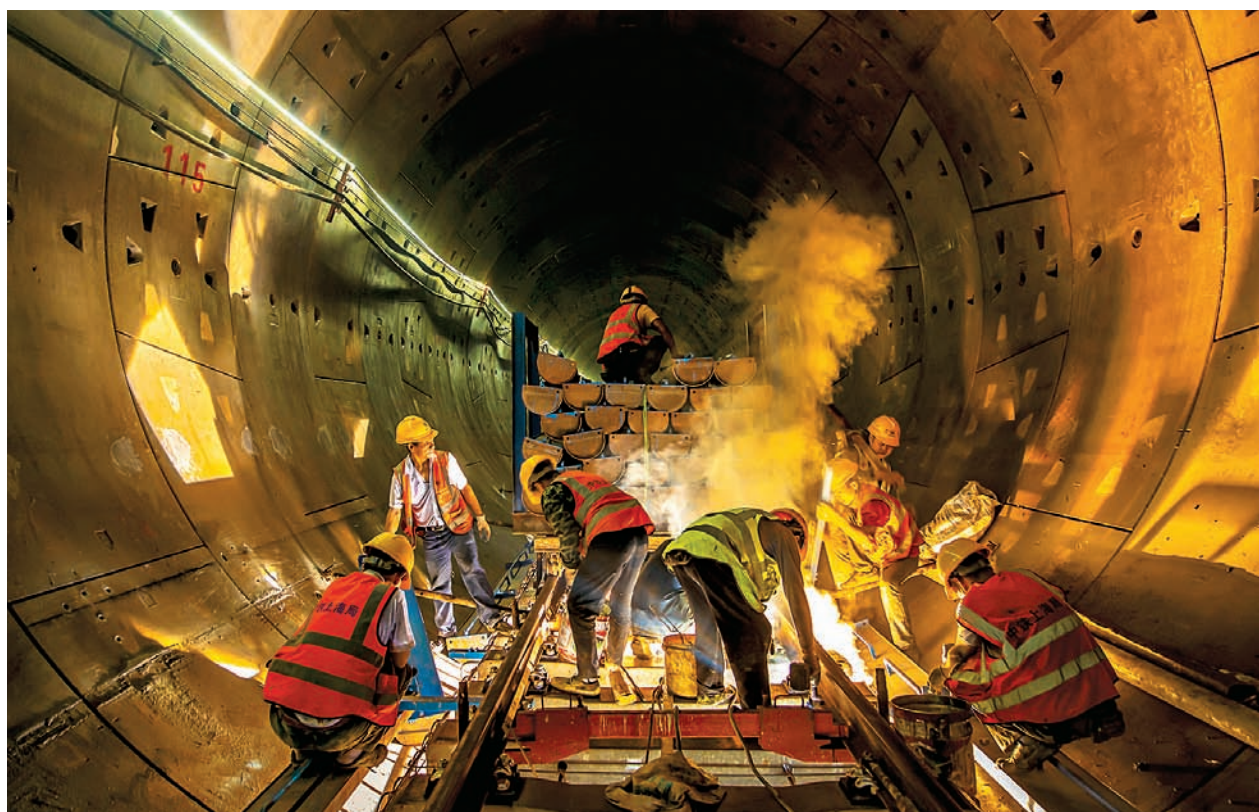
图 34 2019 年 9 月 8 日，地铁施工人员在隧道内铺轨（区域城际铁路建设指挥部提供）
