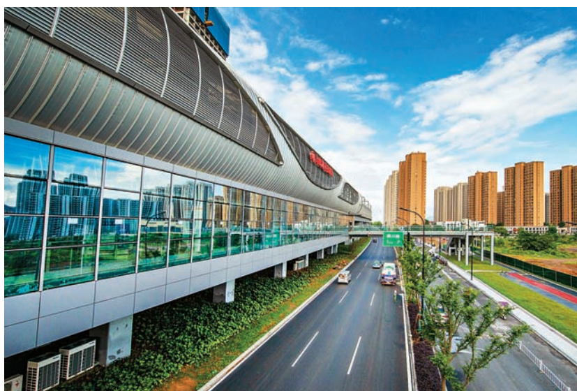
图 38 杭州地铁 16 号线青山湖科技城站（区域际铁路建设指挥部提供）
