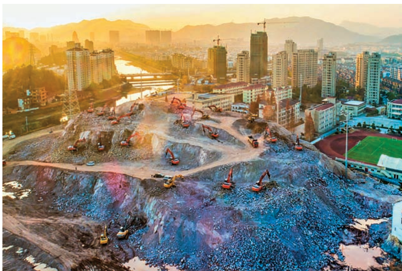
图 28 2017 年 12 月，施工中的农林大学站（区域城际铁路建设指挥部提供）
