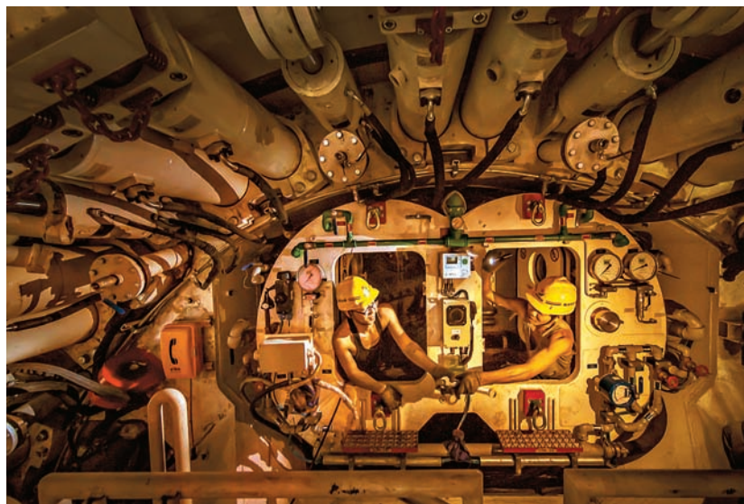
图 31 2018 年 5 月 24 日，地铁 施工人员检修盾构机（区域际 铁路建设指挥部提供）
