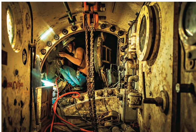
图 30 2018 年 1 月 13 日，地铁 施工人员在隧道内施工（区域 际铁路建设指挥部提供）
