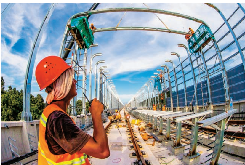
图 35 2019 年 7 月 31 日，地铁施工人员开展防护工程架设（区域城际铁路建设指挥部提供）
