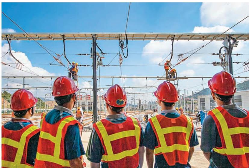
图 36 2019 年 8 月 6 日，地铁施工人员开展输电线路架设（区域城际铁路建设指挥部提供）
