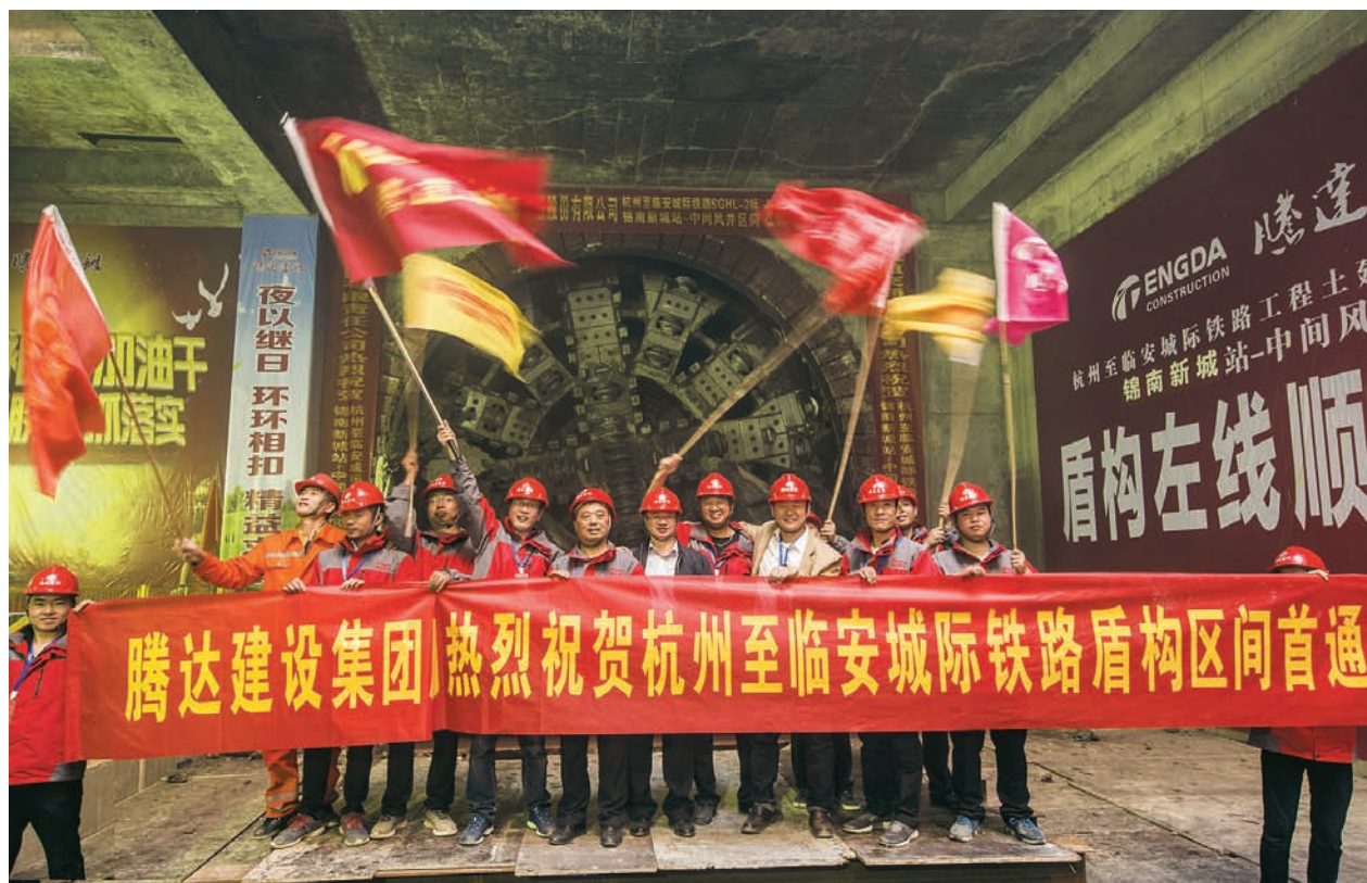
图 33 2018 年 10 月 30 日，锦南新城站—锦临区间风井左线盾构机到达中间风井，杭临城际铁路“第一洞”贯通（区域城际铁路建设指挥部提供）
