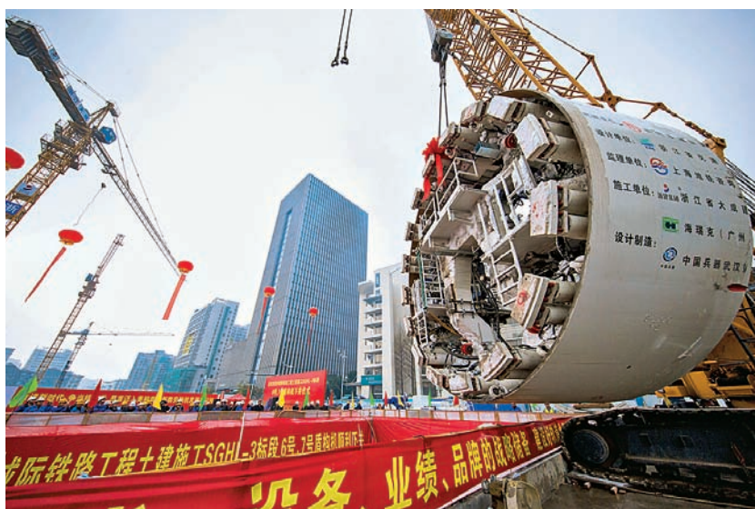
图 29 2018 年 1 月 29 日，杭临城际铁路盾构机在临安广场站下井作业（区域城际铁路建设指挥部提供）
