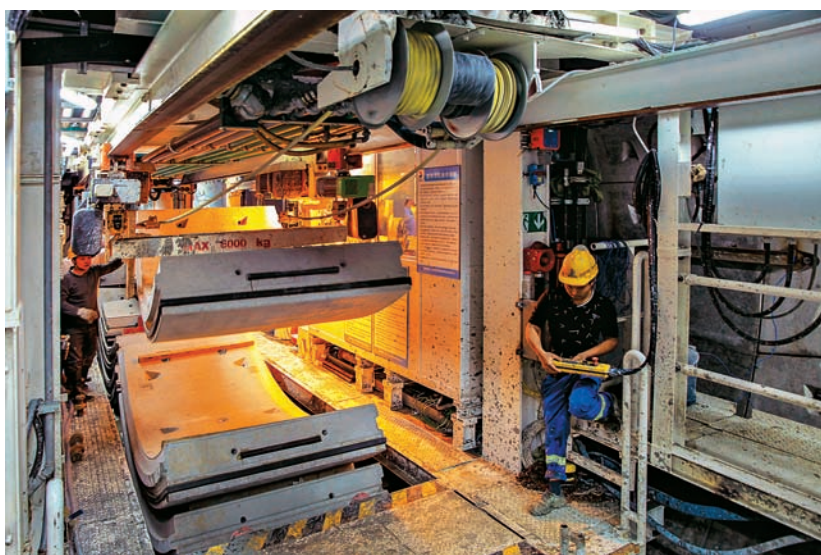
图 32 2018 年 4 月 30 日，地铁 施工人员开展管片传送作业 （区域际铁路建设指挥部提供）
