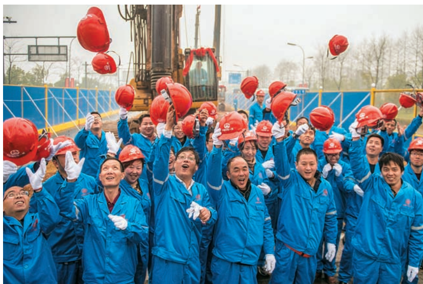
图 27 2016 年 1 月 4 日，杭临城际铁路开工建设（区域城际铁路建设指挥部提供）
