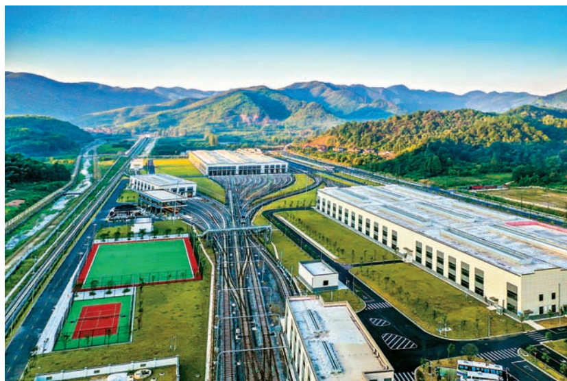
图 40 杭州地铁 16 号线上泉维修基地（区域际铁路建设指挥部提供）
