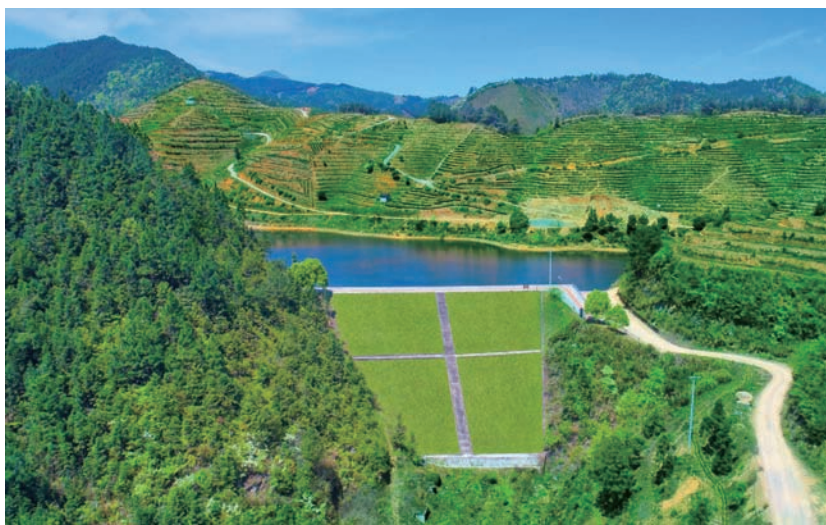
图 120 除险加固后的沈家坞水库(区水利水电局提供)
