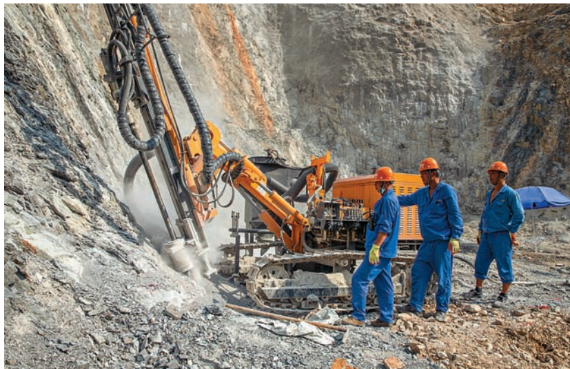
图116 2020年7月22日,施工人员开展双溪口水库外坝坡清理工作(区水利水电局提供)
