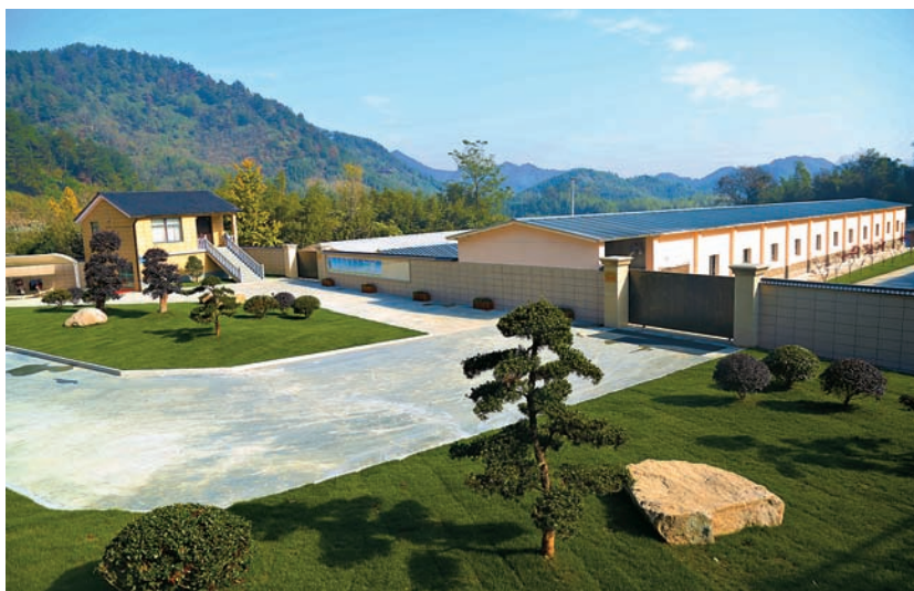
图 112 临安大庆禽业有限公司养殖场（区农业农村局提供）
