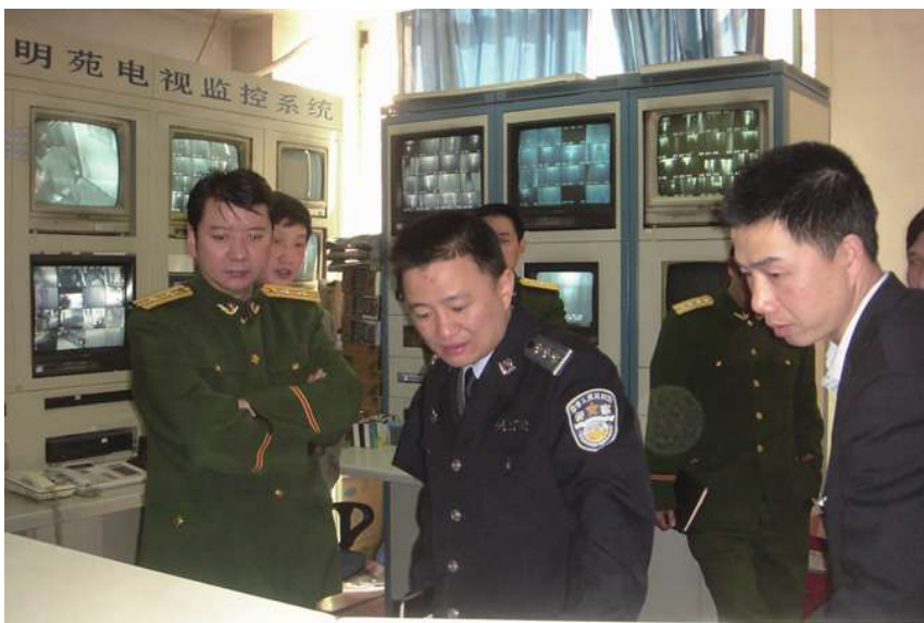
对辖区重大火灾隐患单位进行督察
