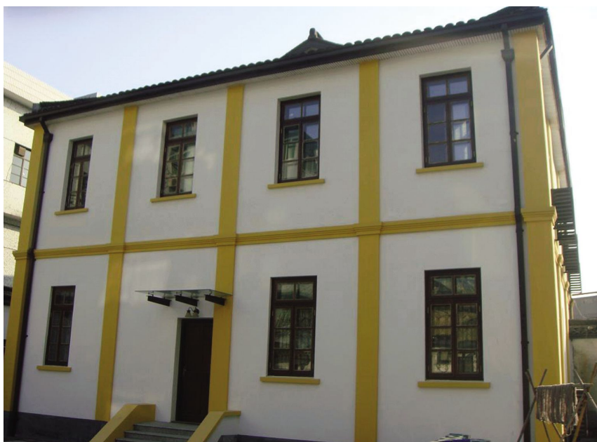
环城东路16-1号民居修缮后
