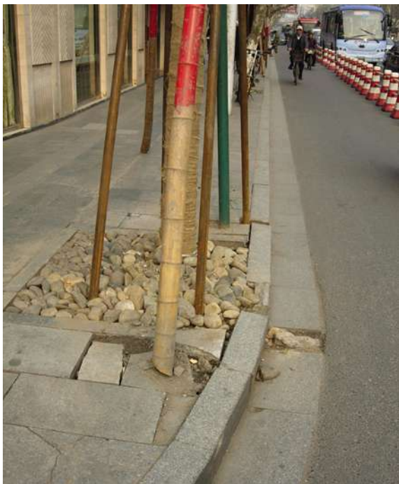
修善前的道路
