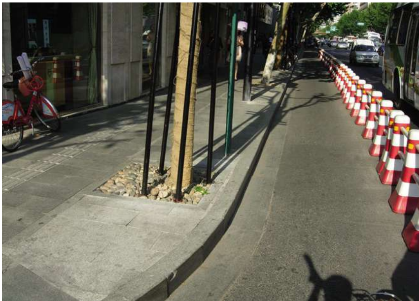
修善后的道路
