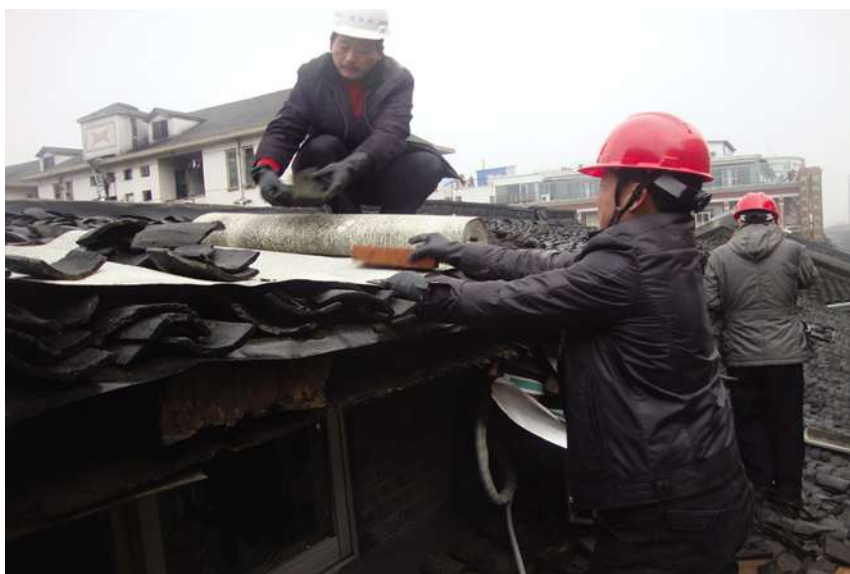
工作人员修缮公房屋顶
