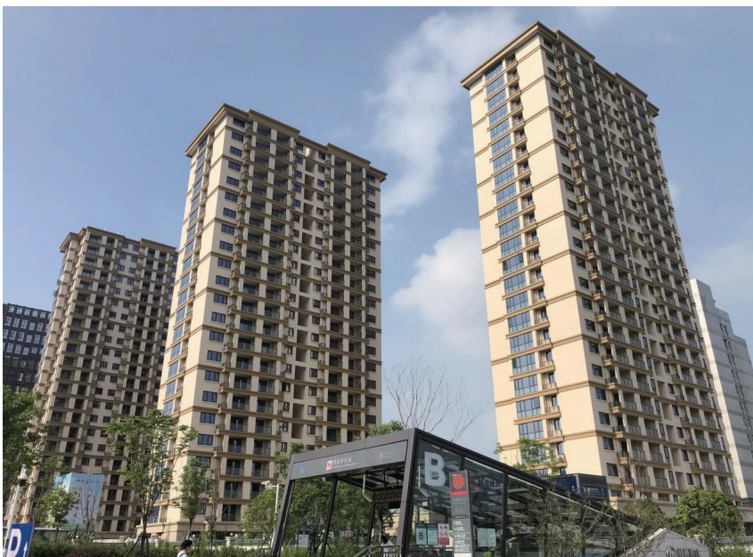
2020 年 5 月 11 日，拱宸桥单元地块拆迁安置房项目交付
