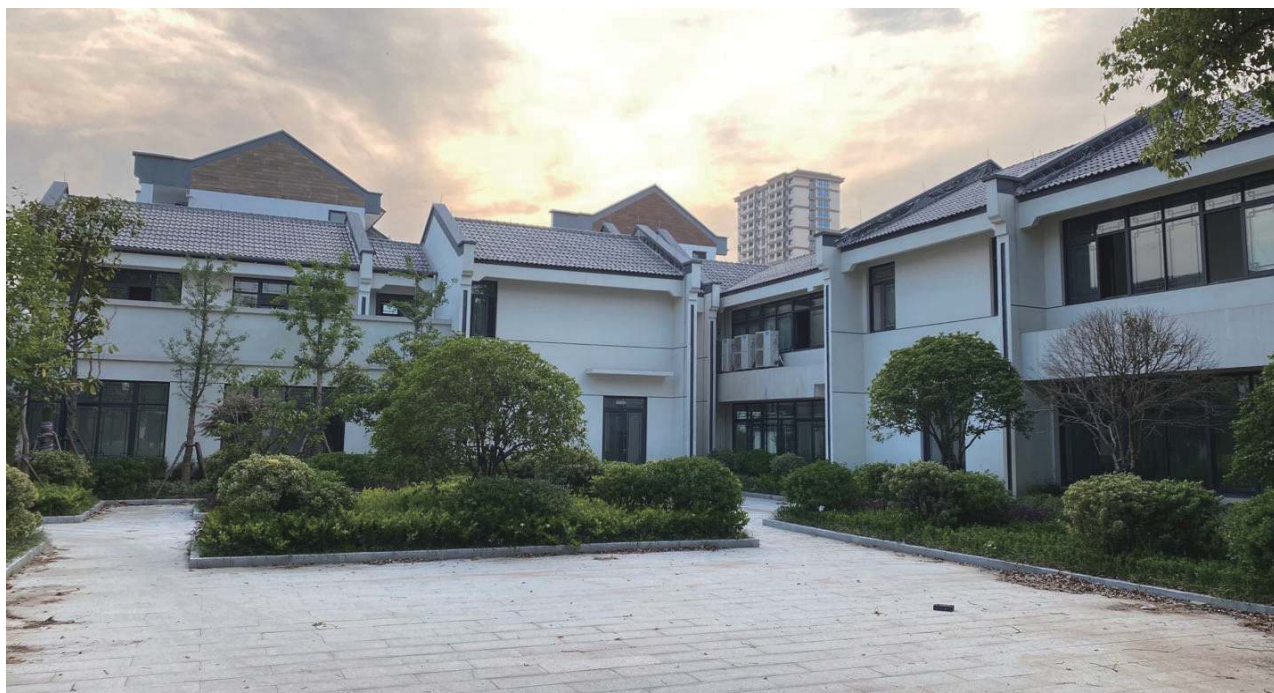
2019 年 12 月 9 日，陆家坞保留农居点整治项目竣工
