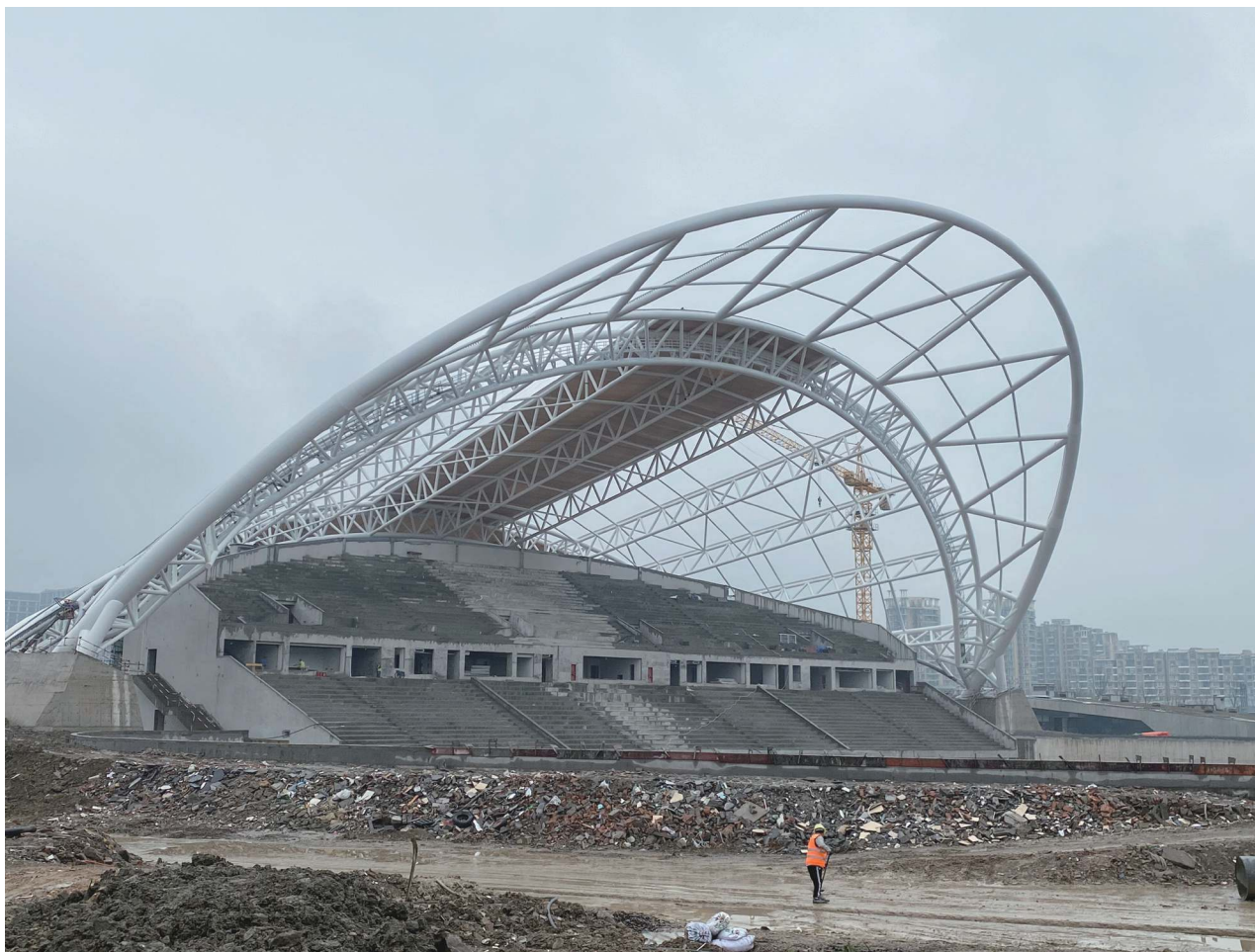
施工中的运河亚运公园
