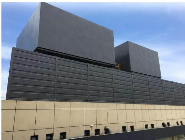
图 7-3-4 类似机力通风冷却塔消声、隔声措施实施效果图
