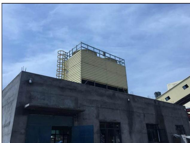
图 7-3-1 拟建项目机力通风冷却塔现场照片
