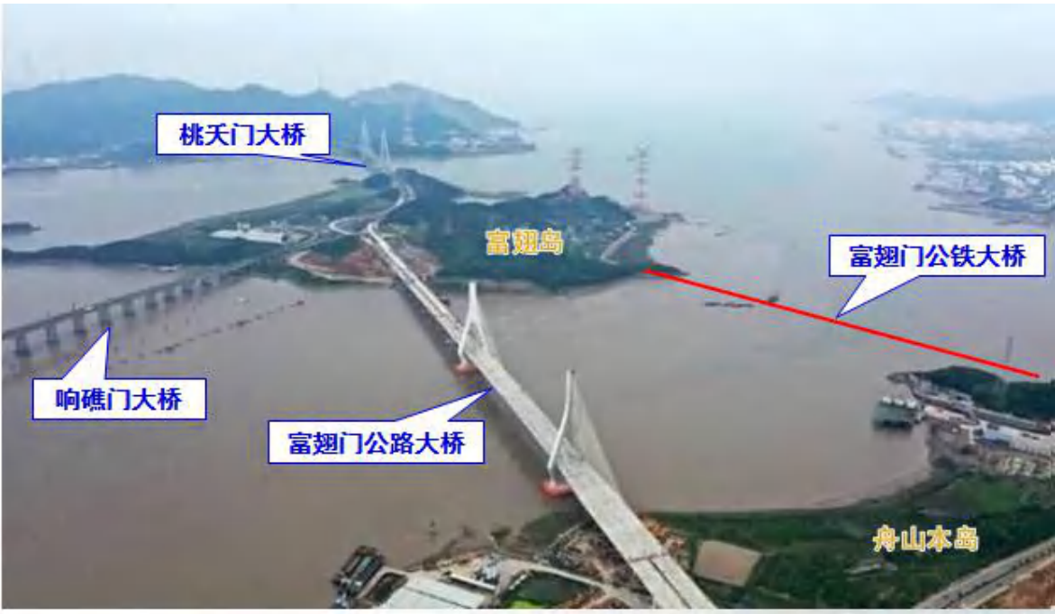
图 2.1-25 拟建富翅门公铁大桥工程地理位置航拍图
