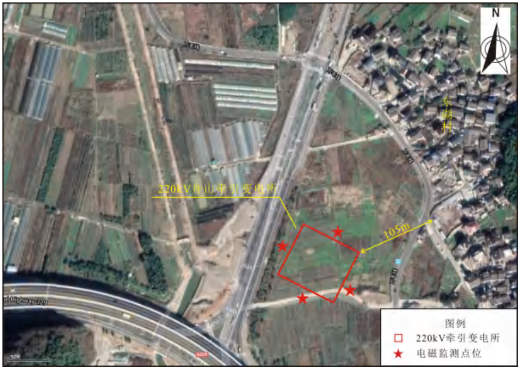
图 8.2-4 220kV 舟山牵引变电所周边环境及监测点位图
